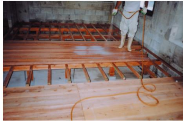
写真：土台・大引・床板
