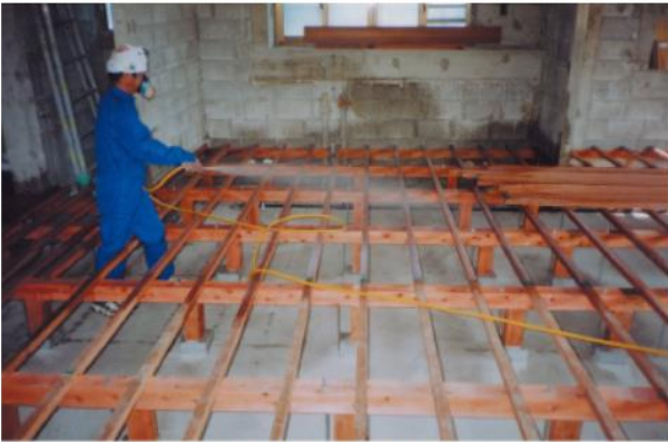
写真：防アリ剤 散布中
