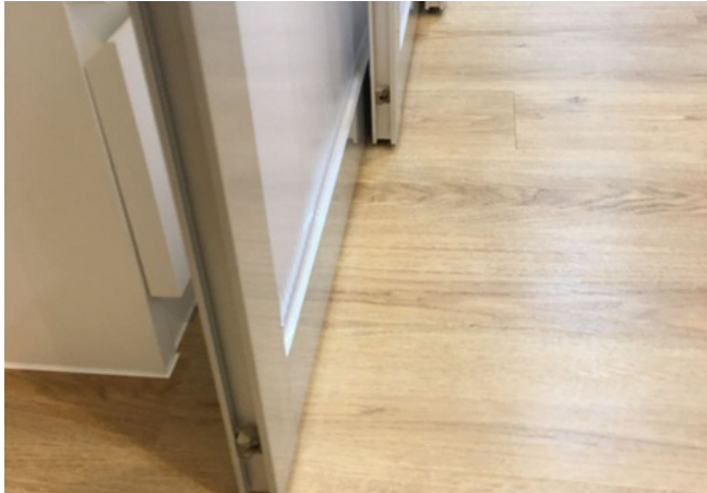
引戸を磁石が床と空中 固定 (リニア式)
