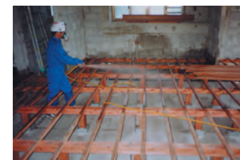
写真: 防蟻剤 散布中
