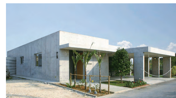
うるま市 Y邸 コンクリート打放し 無機質なデザインが好み。
