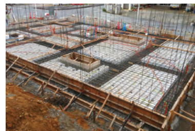
基礎コンクリート打設前
