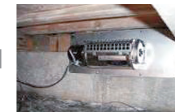
床下換気ファンを取付けても・・・
