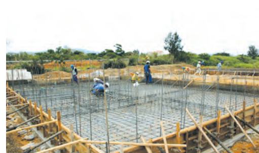
写真: 大きな大きな耐圧盤基礎
