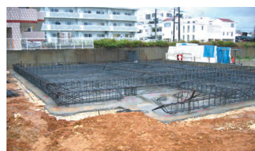
写真: 配筋完了 すごい量の鉄筋です。
