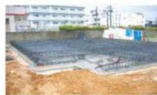
写真：すごい鉄筋量。配筋完了
