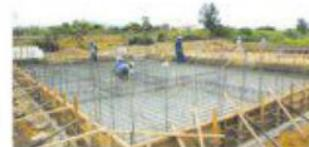
写真：大きな大きな耐圧盤基礎
