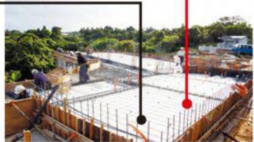
木組の代わりに、床下全体に、保温材を敷込みます。さらに、この上からコンクリートを打設します。
